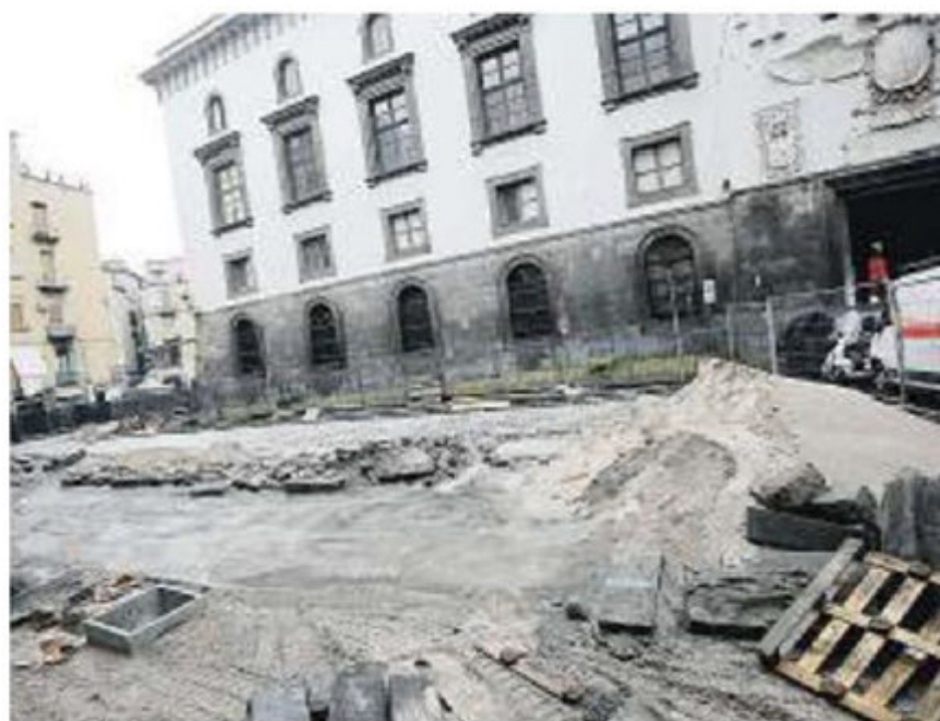
LAVORI IN CORSO Il cantiere davanti Castel Capuano NEWFOTOSUD
