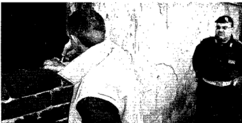
Con i mattoni Agenti e operai comunali murano l'ingresso dell'ex asilo NEWFOTOSUD
