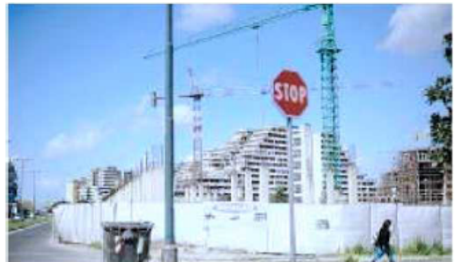
Il cantiere dell'Università a Scampia
