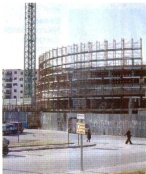
Il cantiere La costruzione dell'università
