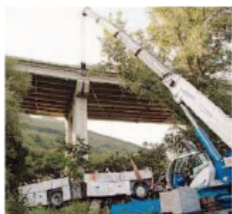
La rimozione del pullman
