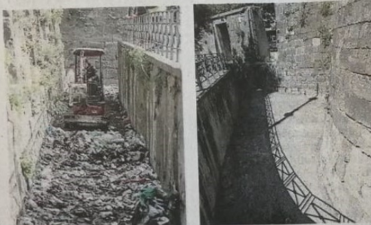
TORRI ARAGONESI II Fossato prima e dopo la bonifica
