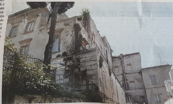
VOMERO Lo storico istituto per ciechi Martuscelli, in alto il degrado all'interno
